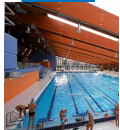
Piscina impermeabilizzata con Mapelastic - Piscina Scarioni - Milano - Italia
