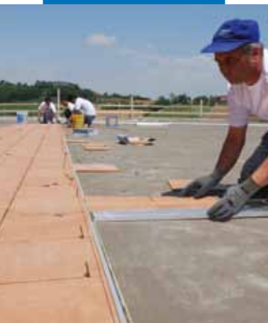
Posa di ceramica con Kerabond + Isolastic
