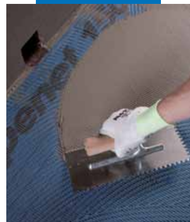
Stesura di Mapelastic su Mapenet 150
