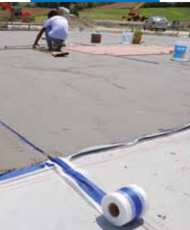
Impermeabilizzazione dei massetti con Mapelastic e Mapeband
