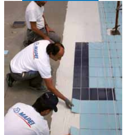
Posa di rivestimento ceramico su Mapelastic
