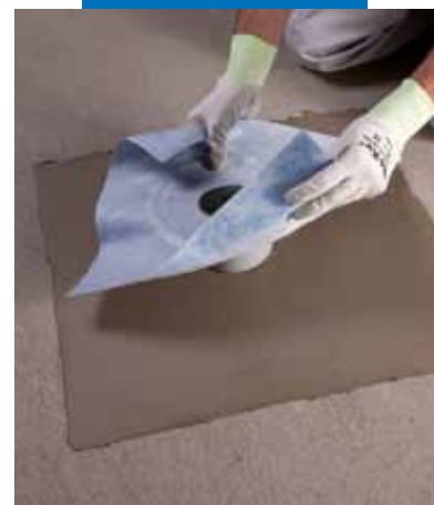
Posa di Drain Vertical, pozzetto di scarico, su Mapelastic
