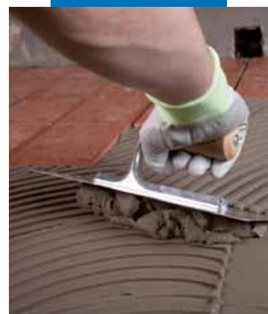
Posa di Granirapid su terrazzo impermeabilizzato con Mapelastic
