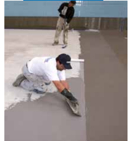
Impermeabilizzazione di una piscina con Mapelastic
