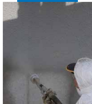
Esempio di applicazione a spruzzo di Mapelastic in un viadotto
