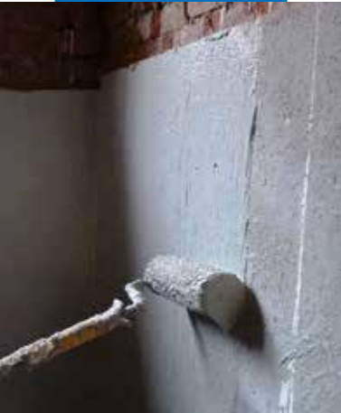
Applicazione di Mapelastic Foundation a rullo su supporto precedentemente regolarizzato con Planitop HDM Maxi
