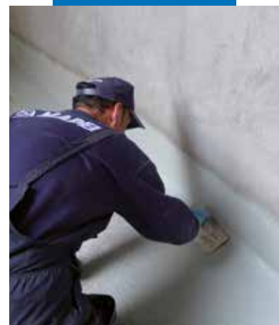
Mapelastic Foundation steso a spatola in un intervento di impermeabilizzazione in contropinta
