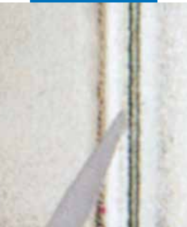
Sigillatura di vetri profilati ad U
