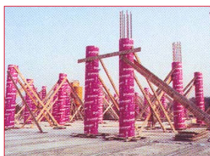
CONVENIENZA E RISPARMIO NELL'ESEGUIRE PIU' TETTI CONTEMPORANEAMENTE
