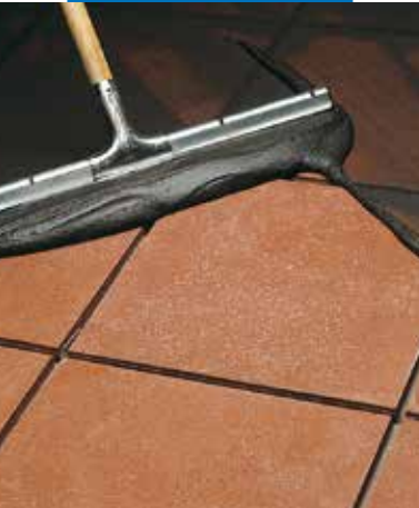
Stuccatura di pavimento in cotto con racla
