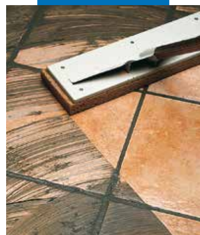
Pulizia di monocottura con spazzolone di spugna
