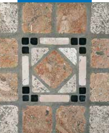
Esempio di stuccatura di pavimento anticato in pietra naturale
