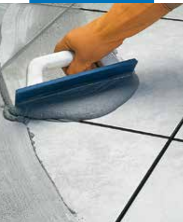
Stuccatura di pavimento ceramico con spatola in gomma
