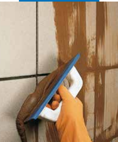
Stuccatura di rivestimento esterno con spatola
