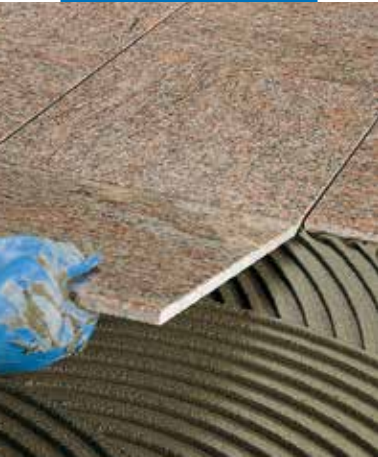
Posa di marmo prelevigato a pavimento
