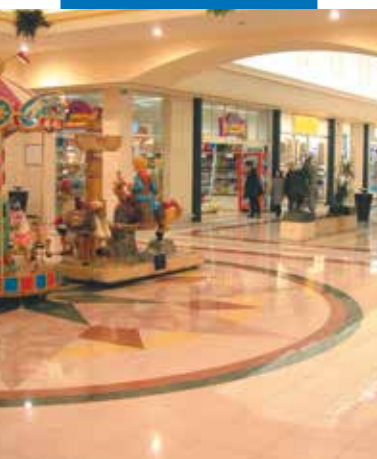
Esempio di posa di grès porcellanato - Centro Commerciale Zanchetta - Treviso
