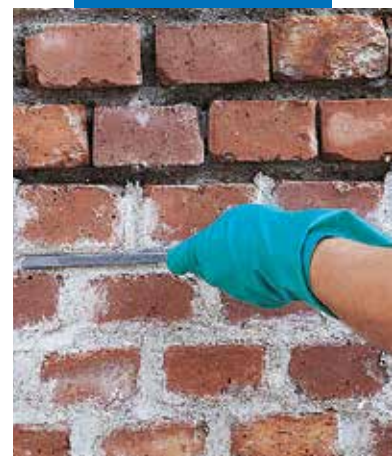
Rifinitura dei giunti di malta stilati con Mape-Antique MC
