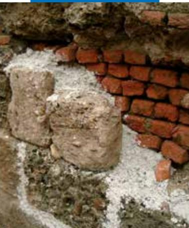
Ricostruzione di una muratura con una malta confezionata in cantiere
