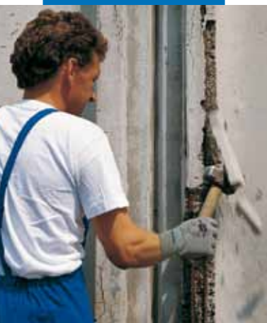
Demolizione del calcestruzzo degradato
