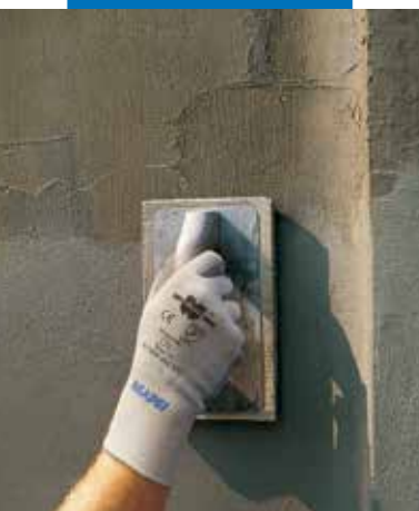
Lisciatura con frattazzo di spugna
