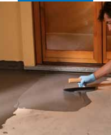
Impermeabilizzazione di terrazzo a spatola
