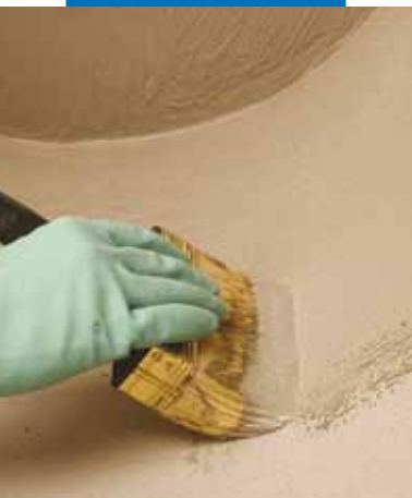
Impermeabilizzazione di dettagli a pennello
