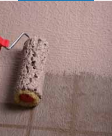
Impermeabilizzazione di terrazzo a rullo
